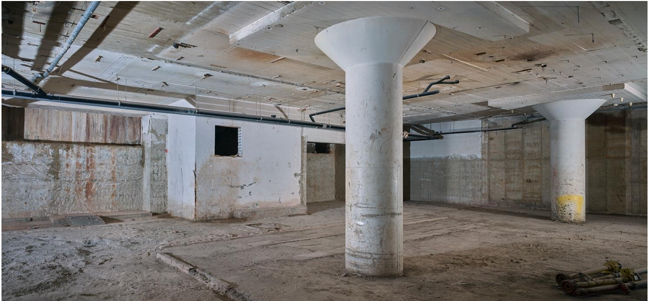
de nieuwe ruimte van voormalig V en D
